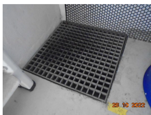
ภาพที่ 2.2-23 บ่อเก็บกากสารเคมีภายในห้องเก็บสารเคมีของ ศูนย์ขนส่งทางอากาศของบริษัทฯ
