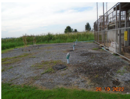
ภาพที่ 2.1-8 ถังเก็บรวบรวมน้ำเสียจากการล้างเฮลิคอปเตอร์ ในกรณีที่ระบบบำบัดน้ำเสียไม่สามารถทำงานได้
